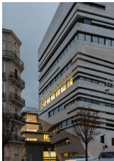
ESAD de Toulon (83) - Architecte : Corinne Vezzoni et associés - © D Huguenin
